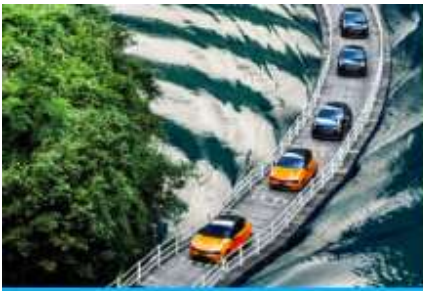
ถนนลอยน้ำด่านสิงโต
