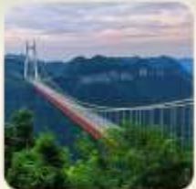
สะพานอ้ายจ้าย
